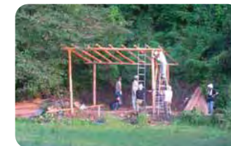
ボランティアによる丸木小屋作りの様子
